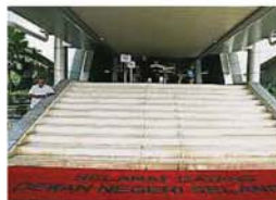
雪州議會仍缺乏全面的殘疾無障礙設施，圖為通往州議會的主入口階梯。
